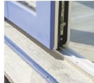
/ Die Aufkantung wurde vom Dachdecker wärmedämmt und abgeklebt.
