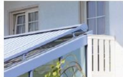
/ Das Oberlicht als Balkongeländer: Teilstücke wurden erhalten und schließen die Lücken zur Hauswand.
