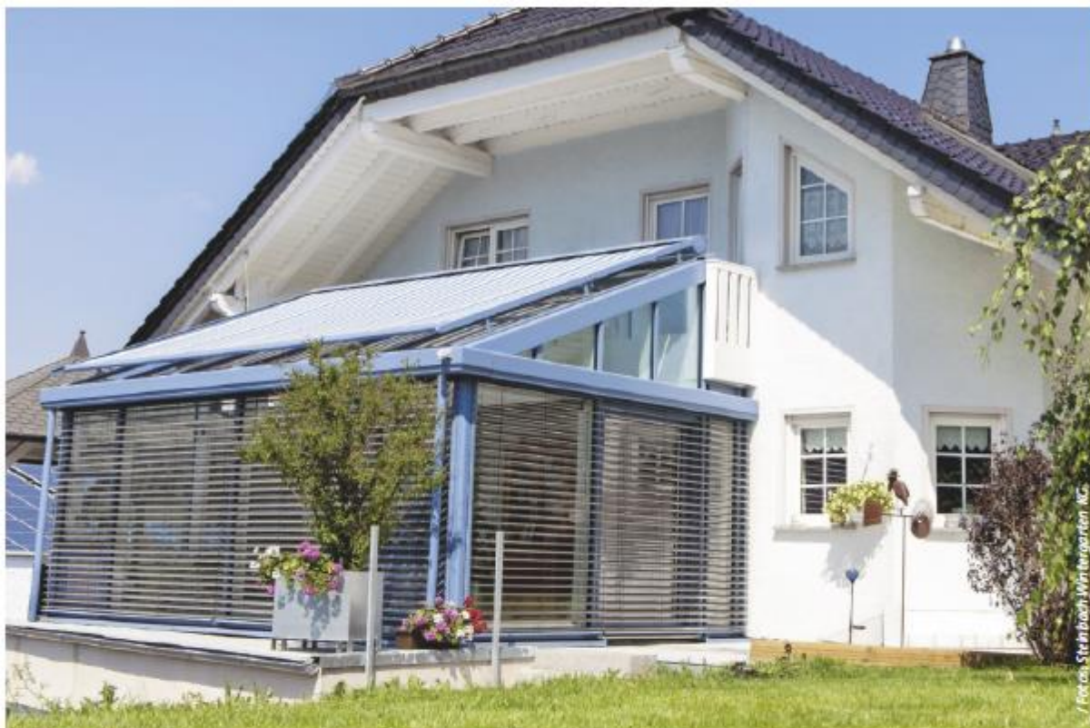
Der Wohnwintergarten auf der Kellerdecke wurde zusammen mit dem Kelleranbau geplant. Ein hohes Pultdach und Außenbeschattungen sorgen auch bei voller Sonne für ein angenehmes Raumklima.
