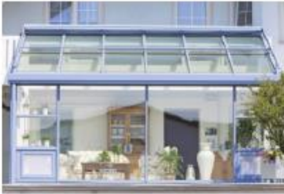
/ Da das Oberlicht als Balkongeländer fungiert, musste Wärmedämmglas mit VSG-Scheiben verbaut werden.
